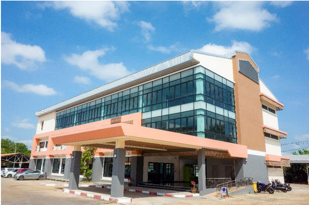
อาคารขวัญแก้ว พื้นที่ 2,280 ตารางเมตร
